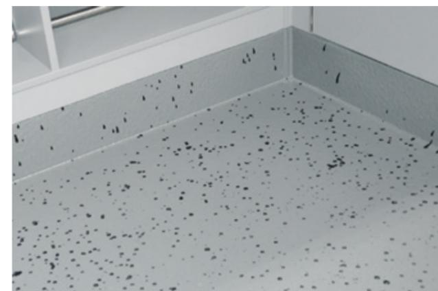
■ **FUSSBODENVERKLEIDUNG:** Spritzfußboden mit Wannenerhöhung – rutschhemmend und leicht zu reinigen.
